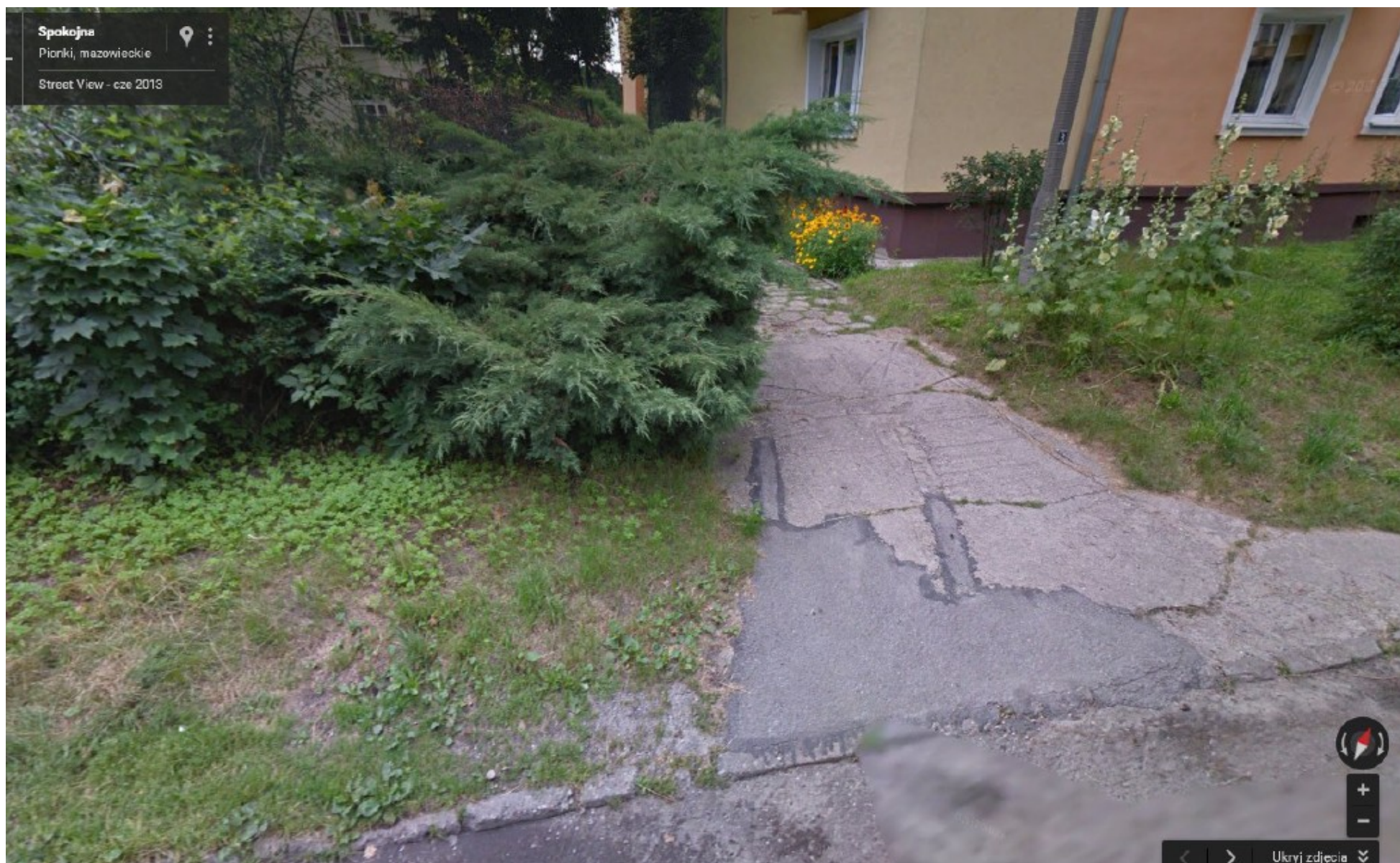
Spokojna 4 - dojazd do budynku od strony południowo-zachodniej.
