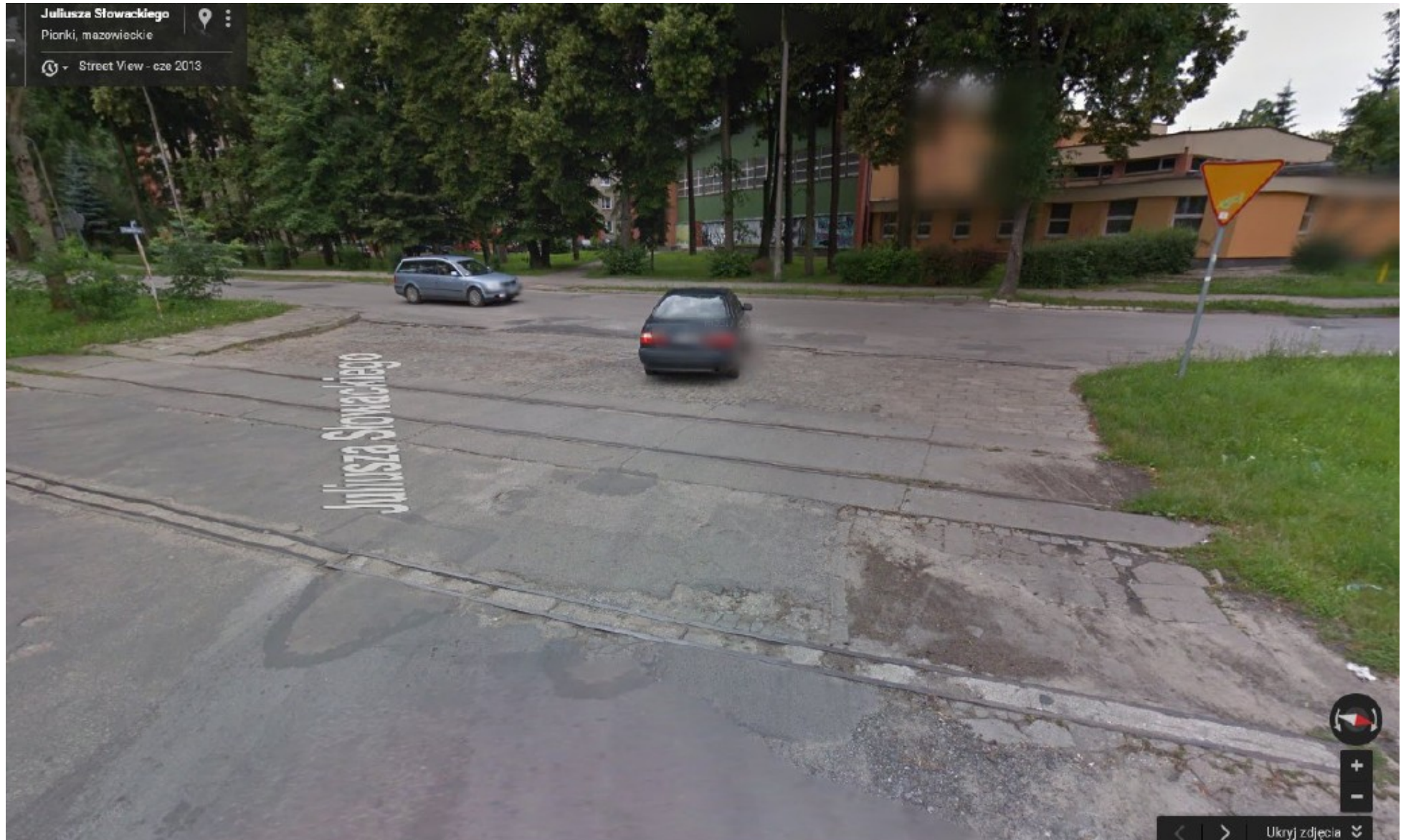
skrzyżowanie ul. Słowackiego z ul. Zakładową w Pionkach
